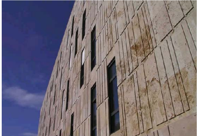
Blick auf einen der beiden oberirdischen, mit Travertin verkleideten Steinquader. Die Fassade erinnert mit ihrem Relief aus unterschiedlich breiten, senkrechten Streifen laut Architekt an Bücherwände oder an Strichcodes und verweist so auf den Inhalt des Gebäudes (©SLUB/Deutsche Fotothek).
