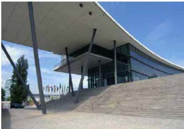
Die Freitreppe des Dresdner Kongreßzentrums.
